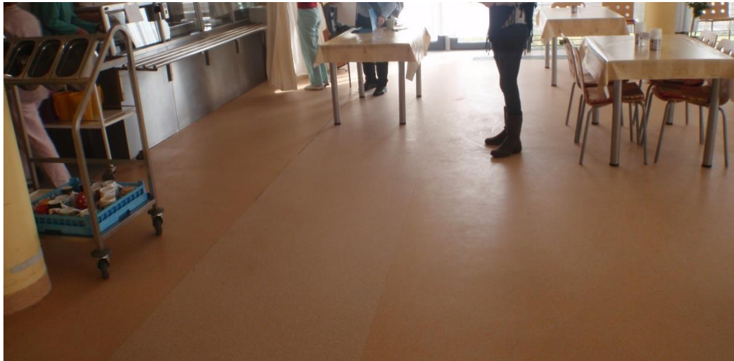
Podlaha v jídelně (objekt B) – porucha spojů, necelistvost
